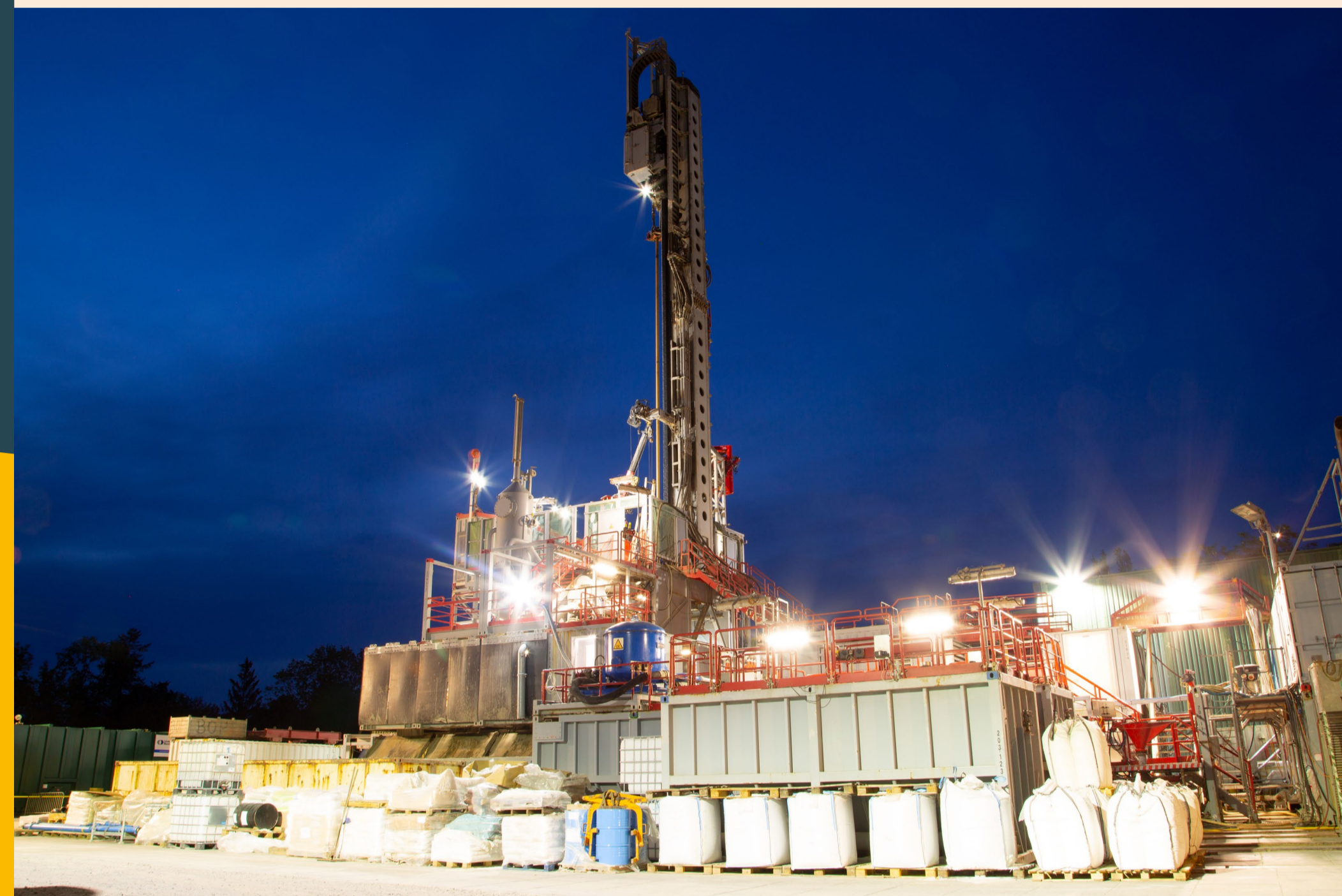
Abb.: Die Geothermie-Bohrung an der Heinrich-Mann-Allee.
