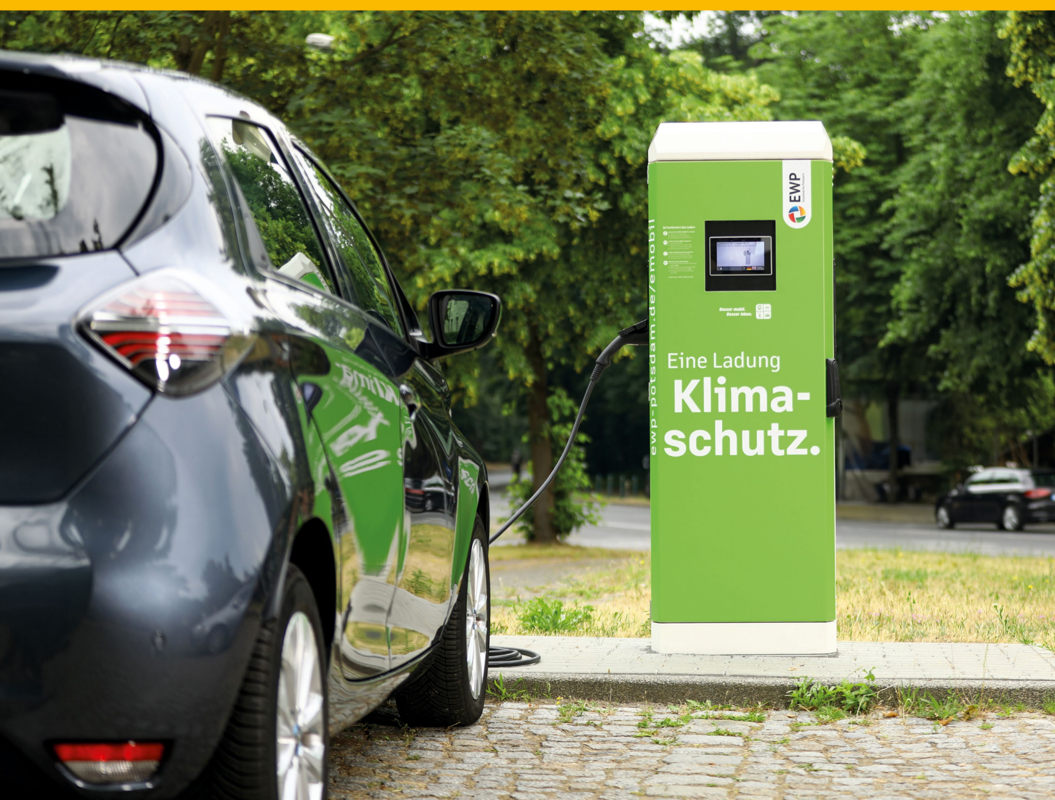
Abb.: Ladesäule der EWP
